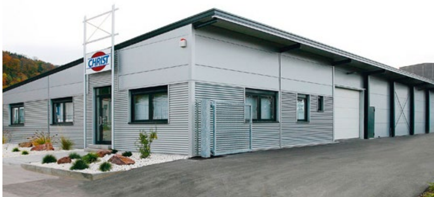
Firmengebäude Fa. Christ, St. Ingbert
